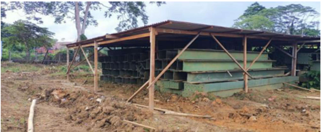
Pekerjaan Fabrikasi Rangka Baja
