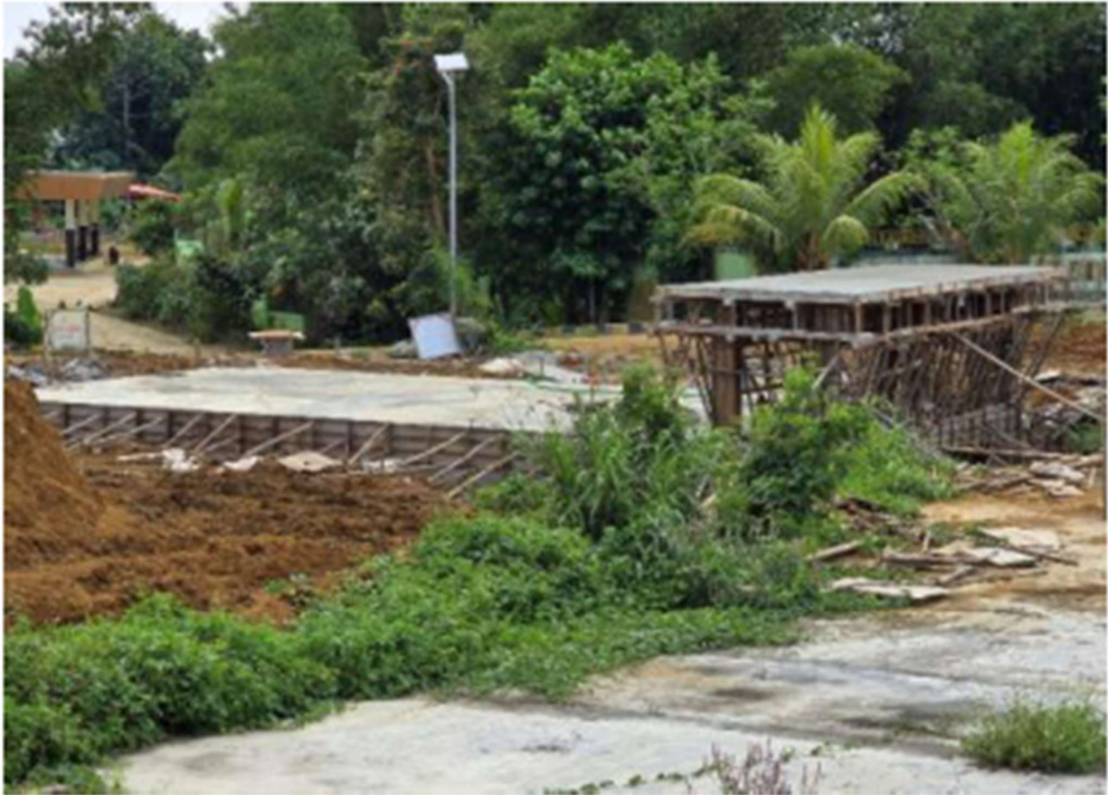
Pekerjaan Groundtank dan Pekerjaan Beton
